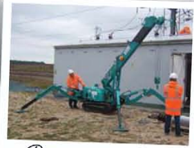
Ремонтные работы на железной дороге
